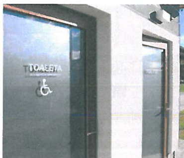
Budowa zaplecza socjalnego - LKS Sęp Droginia
