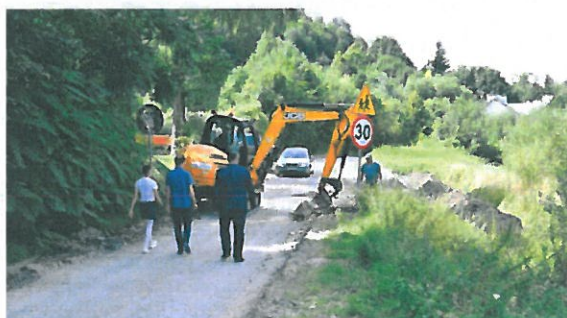
Modernizacja drogi na Chełm
