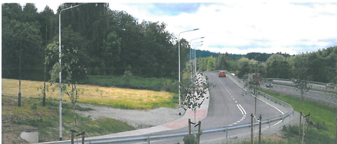
Przebudowa ul. Sobieskiego i ul. Sienkiewicza
