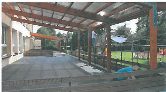
Remont przedszkola nr 6
