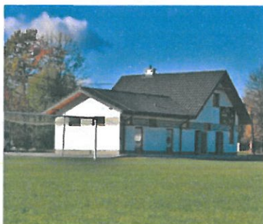
Budowa zaplecza socjalnego - LKS Sęp Droginia
