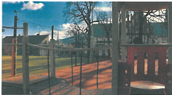
Modernizacja infrastruktury przy Szkole Podstawowej nr 1
