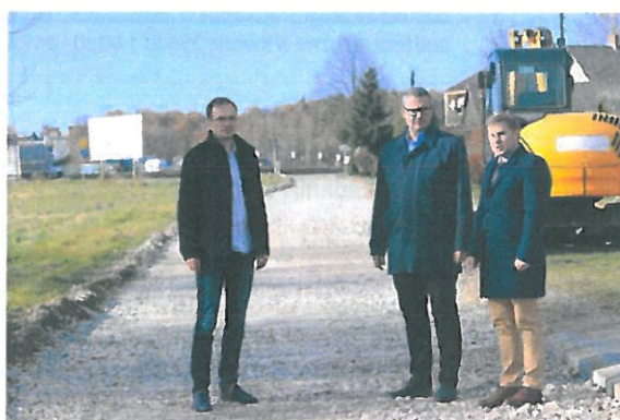
Remont drogi łączącej drogę powiatową z DK7 w Krzyszkowicach
