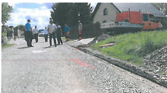
Remont drogi w Głogoczowie
