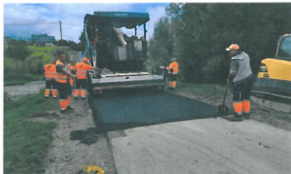
Modernizacja drogi w Krzyszkowicach
