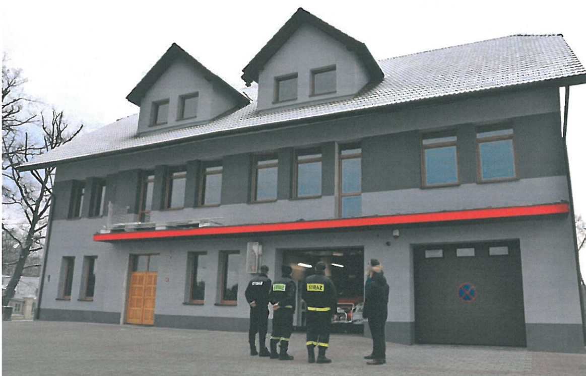
Budynek OSP po termomodernizacji
