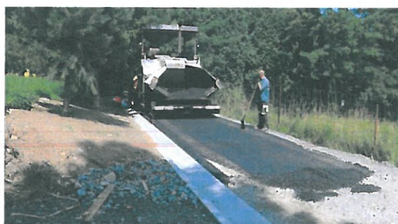
Remont drogi w Głogoczowie
