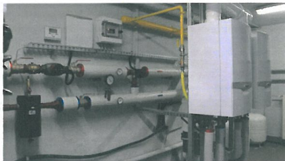
Remont przedszkola nr 6
