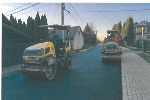
Remont drogi w Polance
