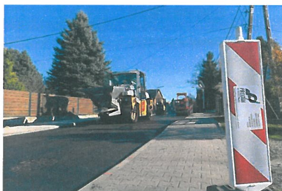
Remont drogi w Polance
