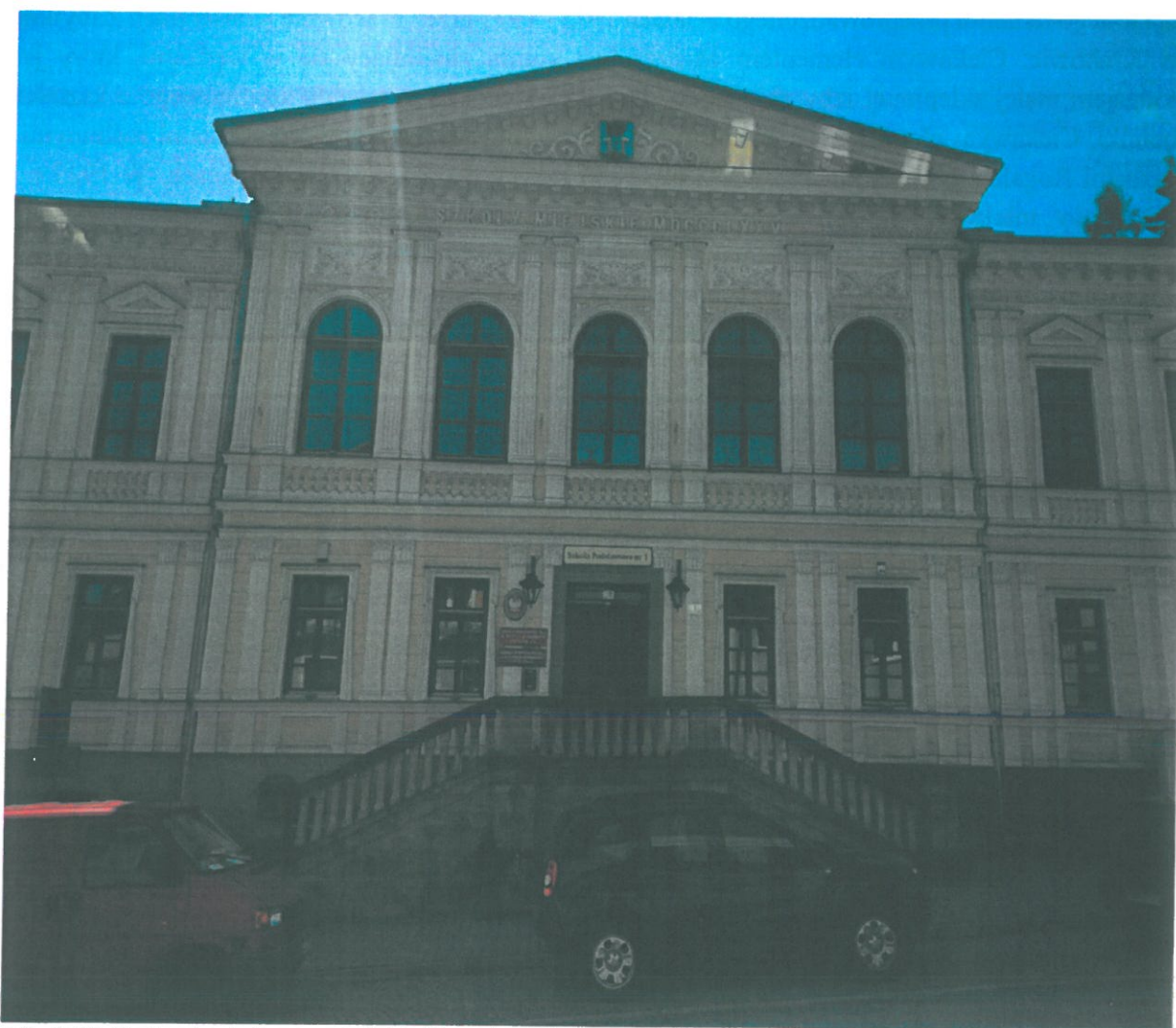
Zdjęcie 30. Budynek szkoły przy ul. Sobieskiego 1 w Myślenicach. (fot. 2020 r.)
