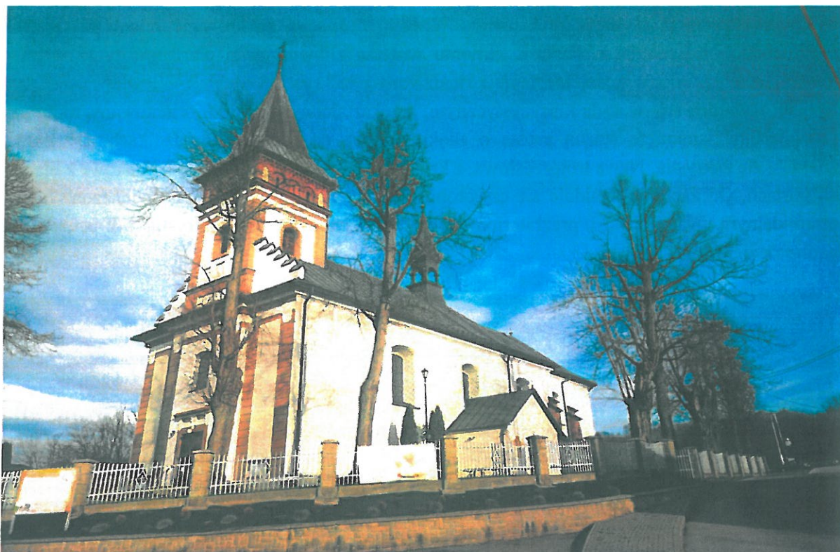
Zdjęcie 2. Kościół w Głogoczowie, widok z boku. (fot. 2020 r.)
