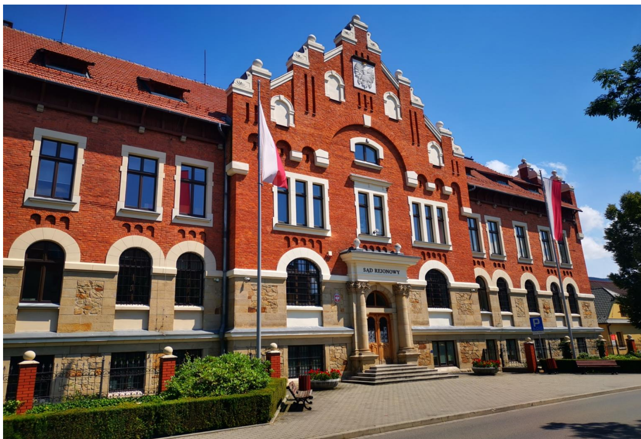
Zdjęcie 17. Budynek Sądu Rejonowego w Myślenicach, ul. Piłsudskiego 7. (fot. 2020 r.)
