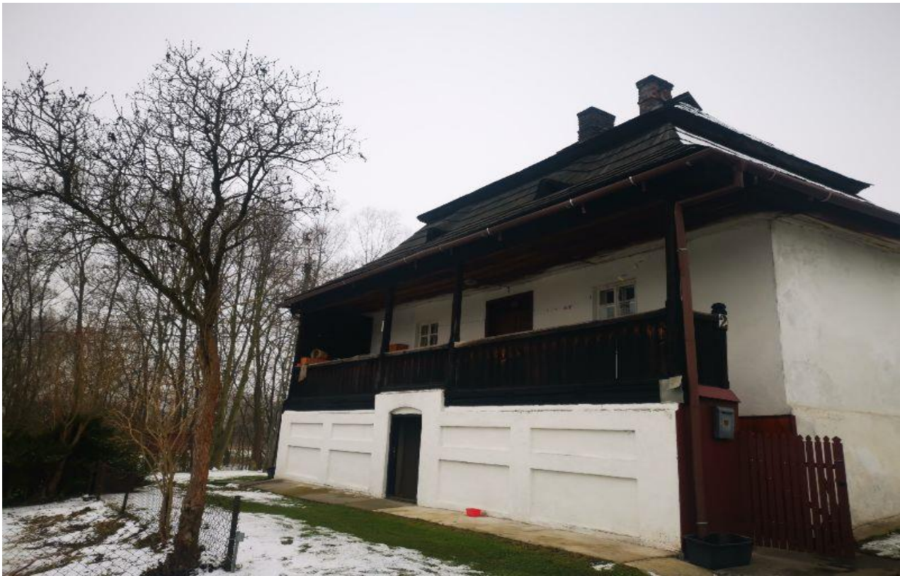
Zdjęcie 5. Lamus w Głogoczowie 2 poł. XVII w. widok od południa, widoczny drewniany ganek. (fot. 2020 r.)
