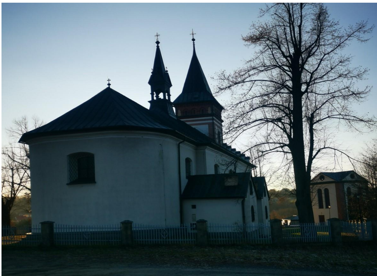
Zdjęcie 3. Kościół w Głogoczowie, widok od strony prezbiterium. (fot. 2020 r.)
