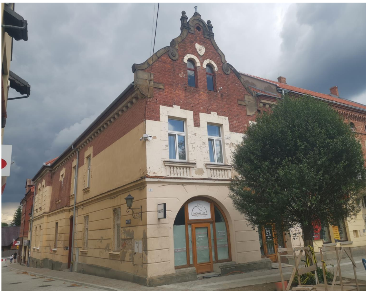
Zdjęcie 22. Kamienica przy Rynku 5 w Myślenicach, wybudowany w 1911 roku, proj. Jan Sas Zubrzycki. (fot. 2020 r.)
