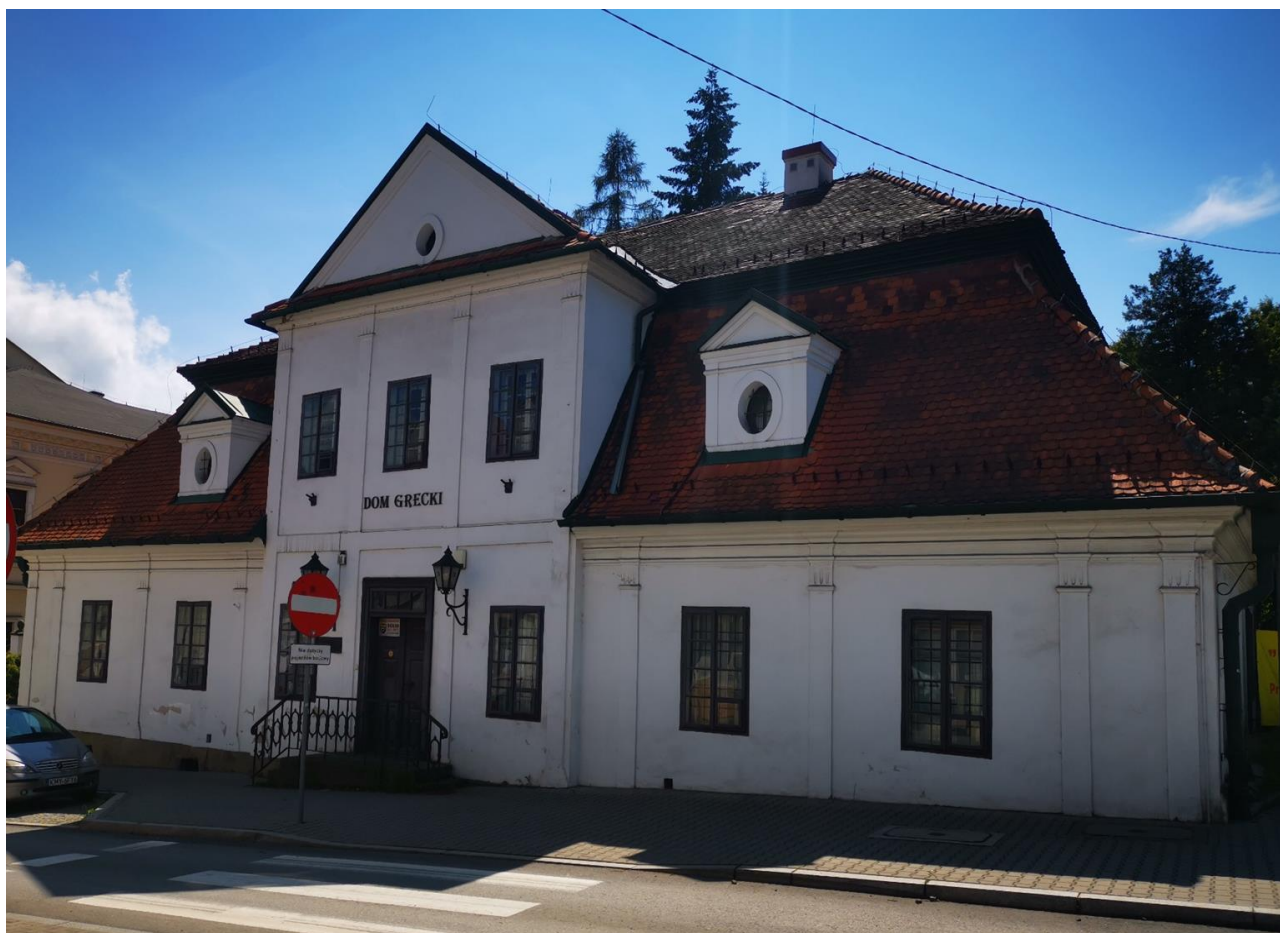
Zdjęcie 31. Budynek przy ul. Sobieskiego 3 w Myślenicach tzw. "Dom Grecki". (fot. 2020 r.)
