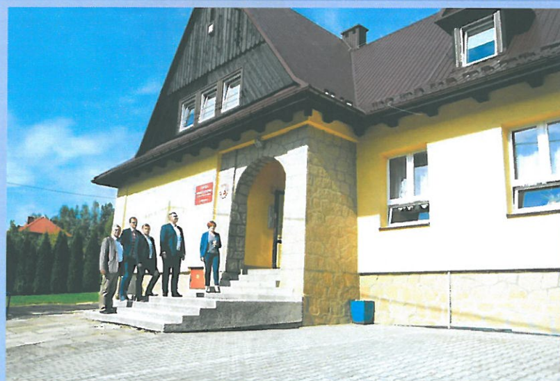
Remont dachu w SP w Bęczarce
