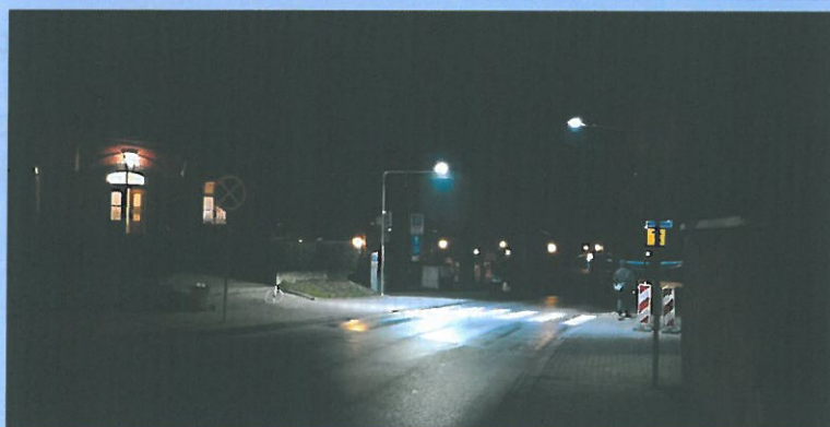
Nowe oświetlenie przejść dla pieszych
