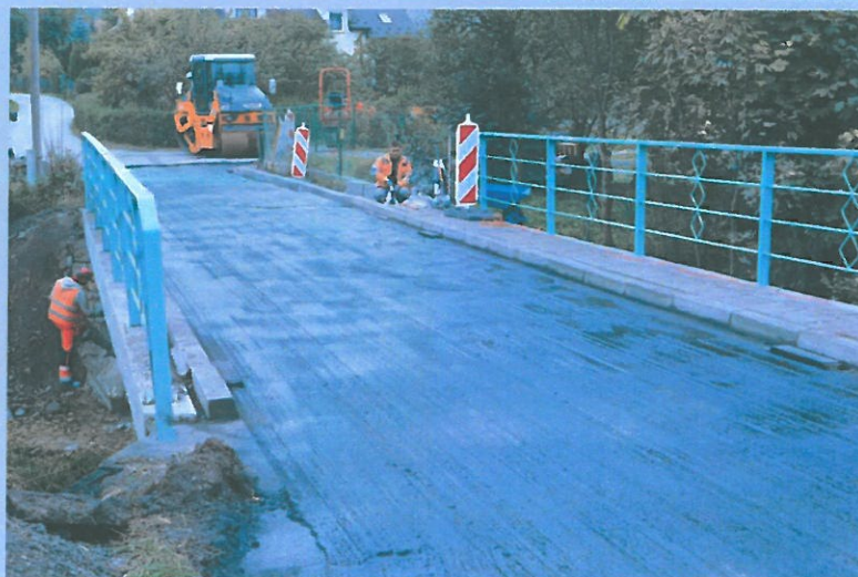
Remont mostu w Trzemeśni
